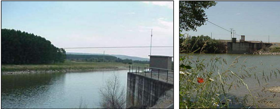
Ilustración 8. Fotografías de la estación de aforo del río Ebro situada en el término municipal de Castejón. Imágenes obtenidas de la página web del SAIH de la Confederación del Ebro.
