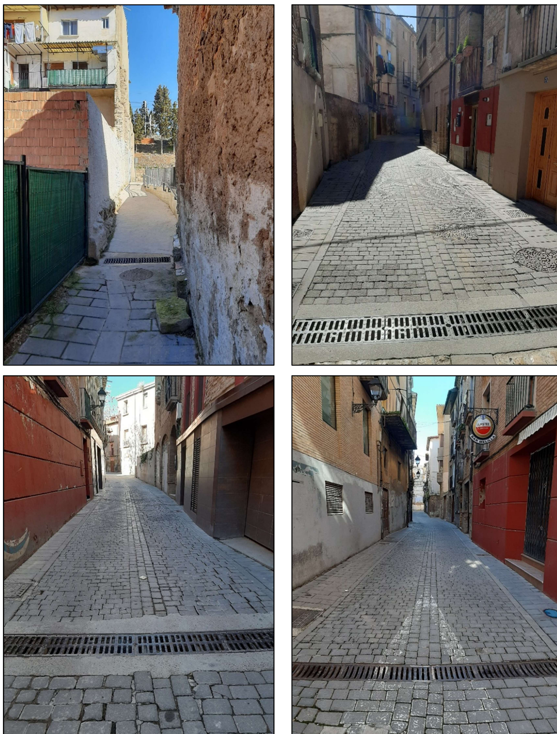
Ilustración 31. Imagen de cuatro de las alcantarillas en puntos bajos en Tudela.
