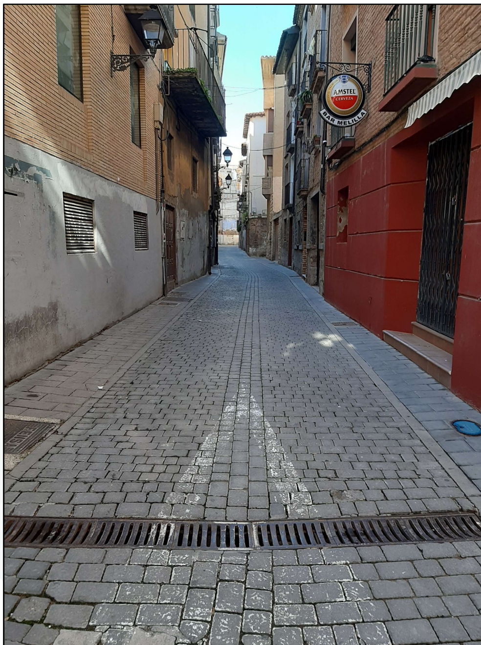
Ilustración 43. Vistas de las calles Verjas, San Julián y Arbolones. Se trata de otra de las zonas donde la inundación, que se inicia por la red de alcantarillado, produce calados de mayor peligrosidad en el casco viejo de Tudela. En estos tramos de dichas calles se une la peligrosidad de haber varios garajes que resultan inundados, así como la existencia de varias tapas de alcantarillado que pueden resultar desplazadas.
