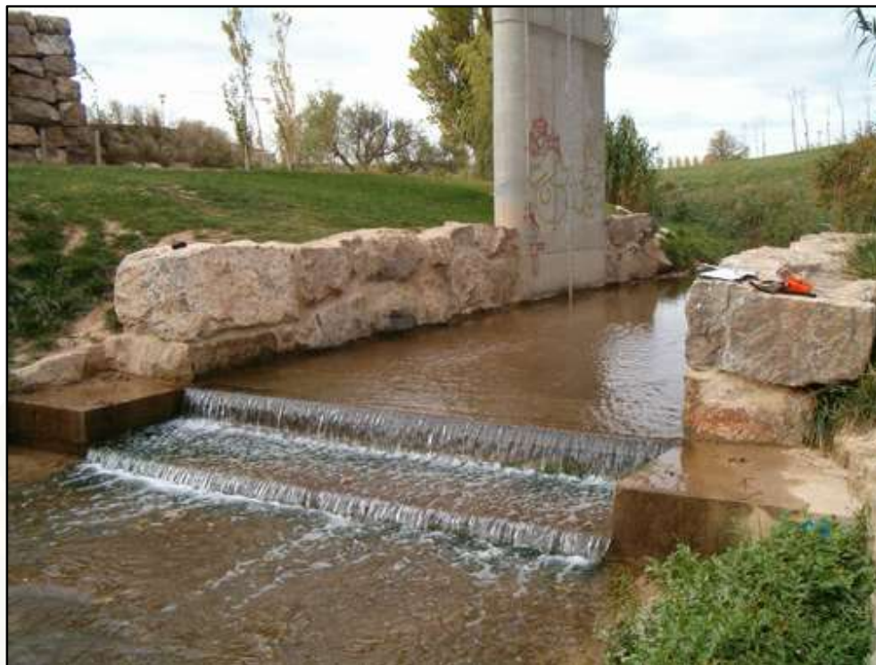
Ilustración 14. Fotografía de la estación de aforo del río Queiles situada en el término municipal de Tudela. Imagen obtenida de la página web del SAIH de la Confederación del Ebro.
