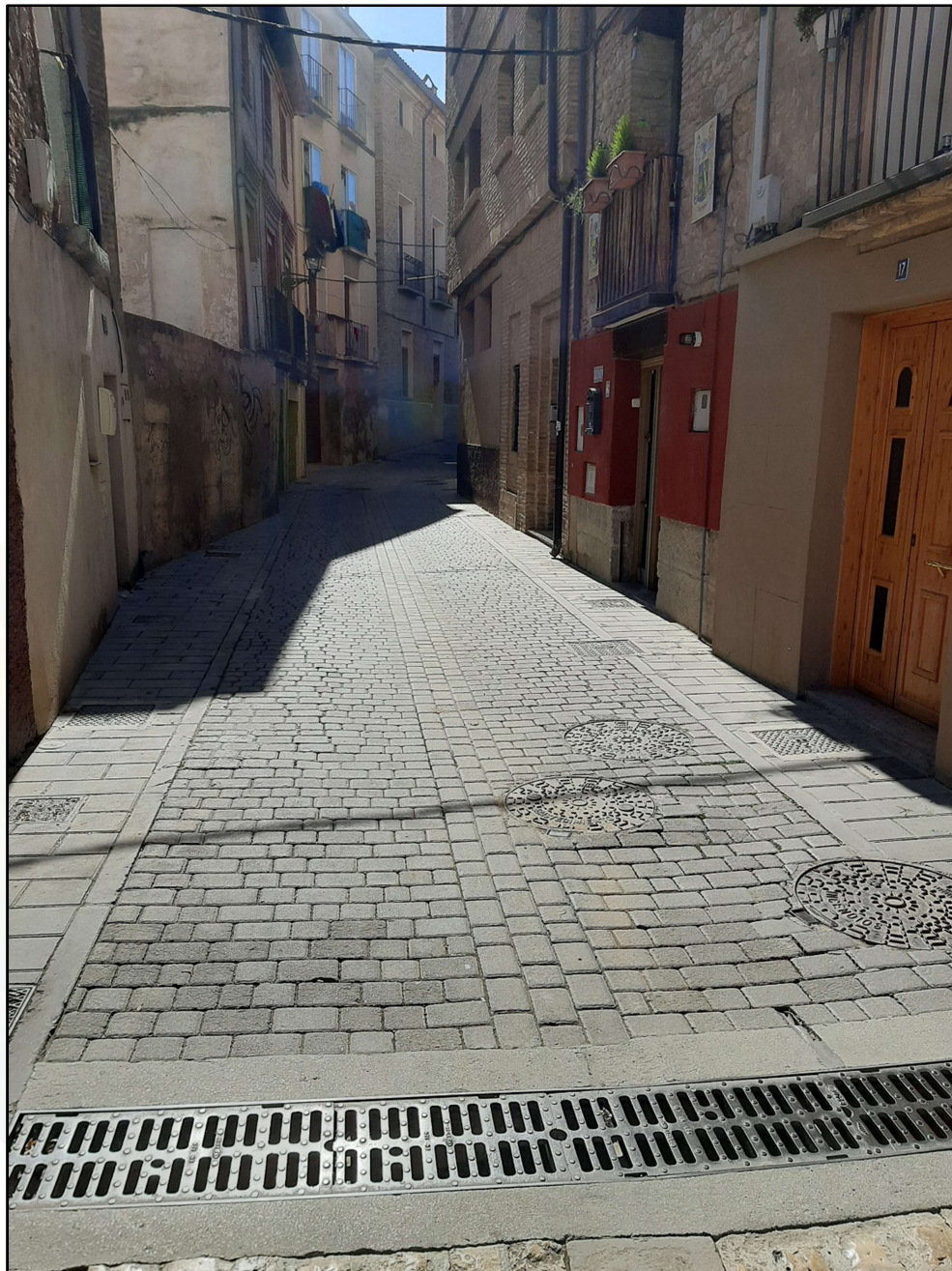
Ilustración 47. Imagen que ilustran los puntos de mayor importancia de la inundación en el entorno de las calles: Fosal, Portal, Pontarrón, Patio y Mediavilla. Se muestran en concreto también las dos alcantarillas principales por las que se inicia la inundación en esta parte de la ciudad.
